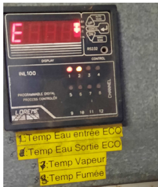
Figure 12 : capteur de température non fonctionnel
