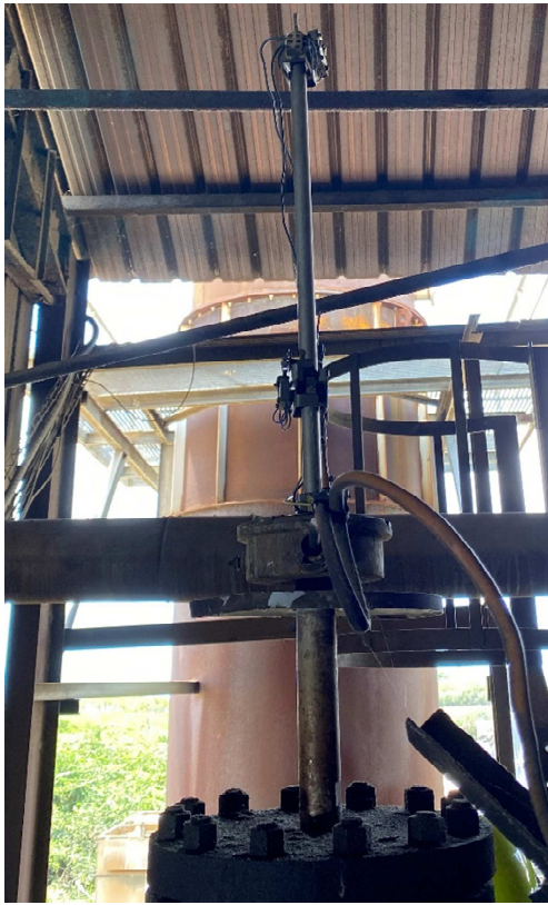
Figure 8 : contacts niveau haut, bas et très bas
