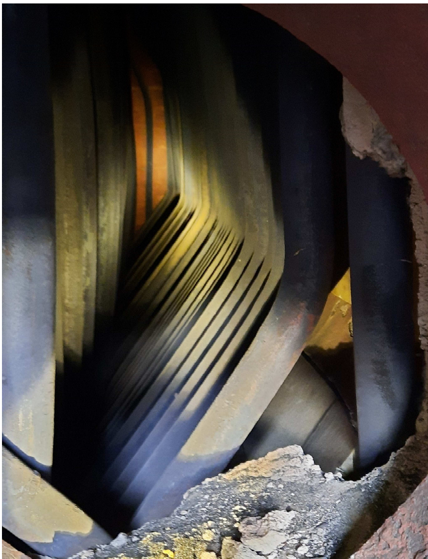
Figure 10: constat de l'endommagement des tubes
