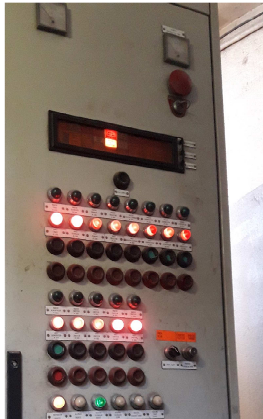
Figure 9 : shunt à clé
