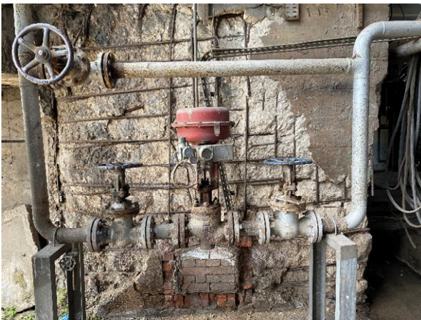
Figure 5 : vanne de régulation
