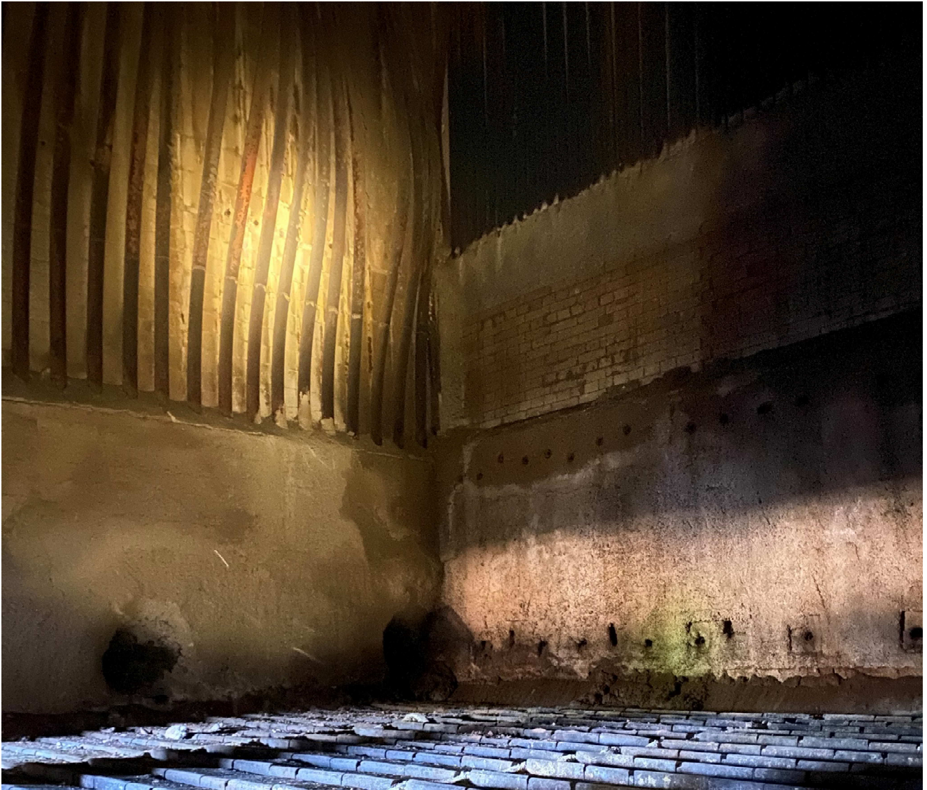
Figure 11 : constat de l'endommagement des tubes
